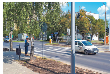
Sygnalizacja świetlna na skrzyżowaniu ulic: Dulebą, Elektryczna i Krańcowa
