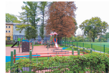
Nowe boisko i termomodernizacja SP 2
